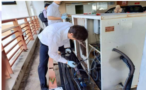
KERJA-KERJA PEMASANGAN SISTEM PENGESAN ULTRASONIK NOVEMBER 2018
